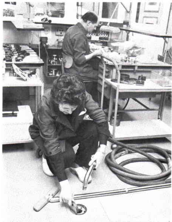
Centralsug inbyggd i anläggningen ger rationellt städresultat (FFV-U/CVM).
